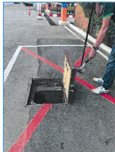
บ่อพักน้ำทิ้งสุดท้ายก่อนระบายออกสู่สาธารณะ
