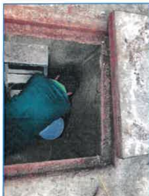
ภาพถ่ายที่ 2.2-6 การขุดลอกท่อระบายน้ำโครงการ
